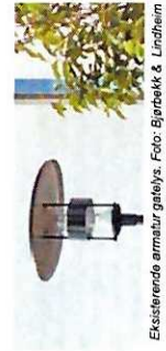
Eksisterende armatur gatelys. Foto: Bjørnbekk & Lindheim
